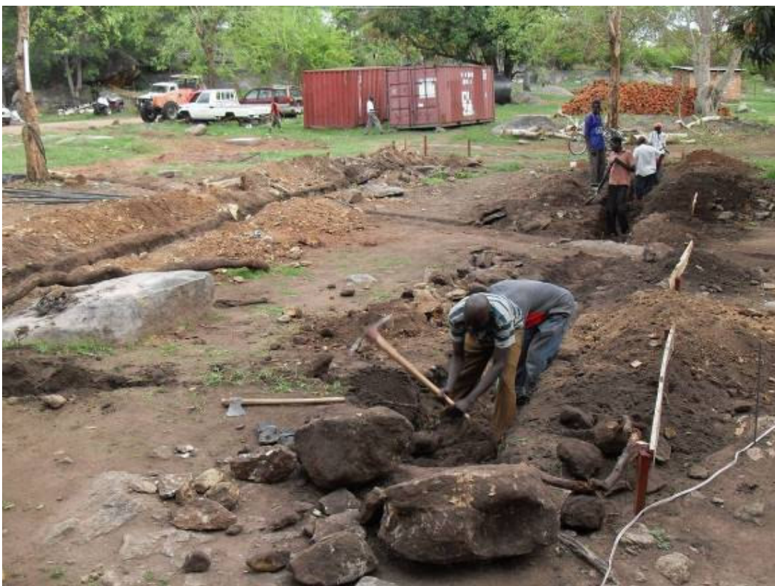
Scavo delle fondazioni (maggio 2011)
