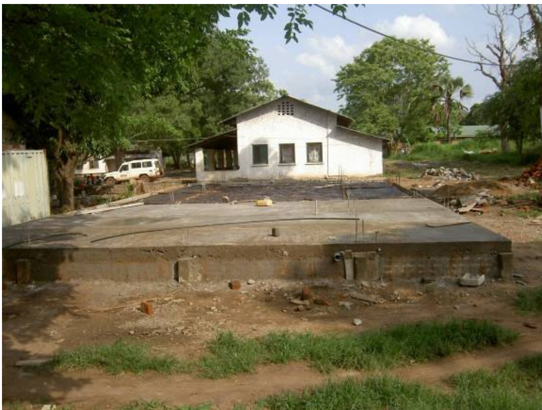
Realizzazione del basamento (luglio 2011)
