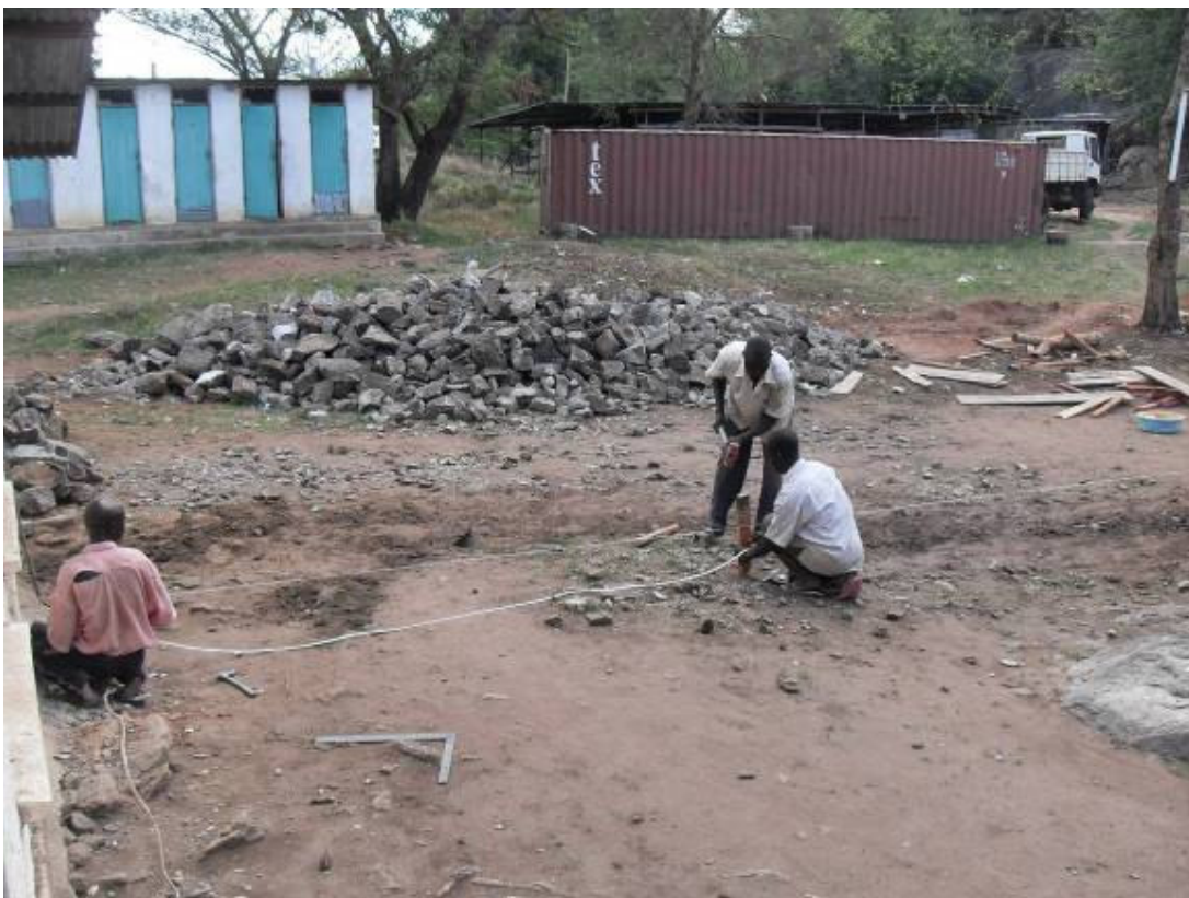
Tracciamento delle fondazioni (maggio 2011)
