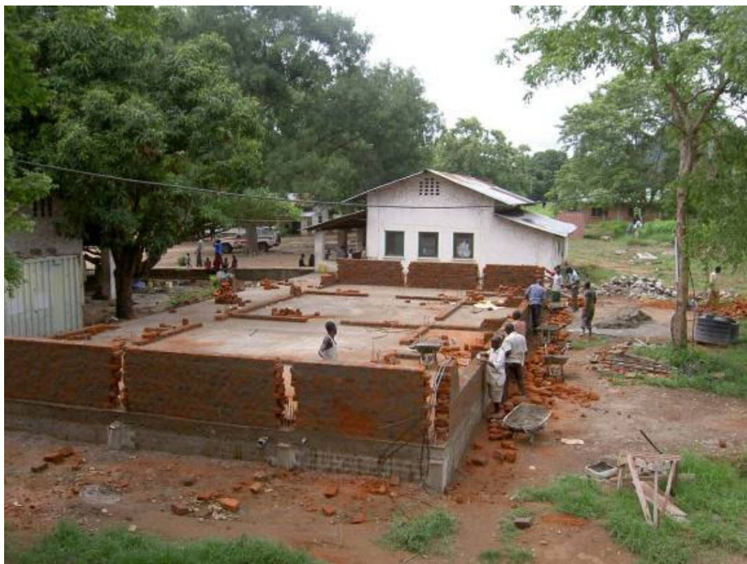
Realizzazione dei muri perimetrali ed interni (Luglio 2011)
