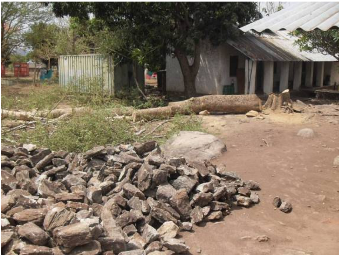
Preparazione del sito di costruzione (aprile 2011)
