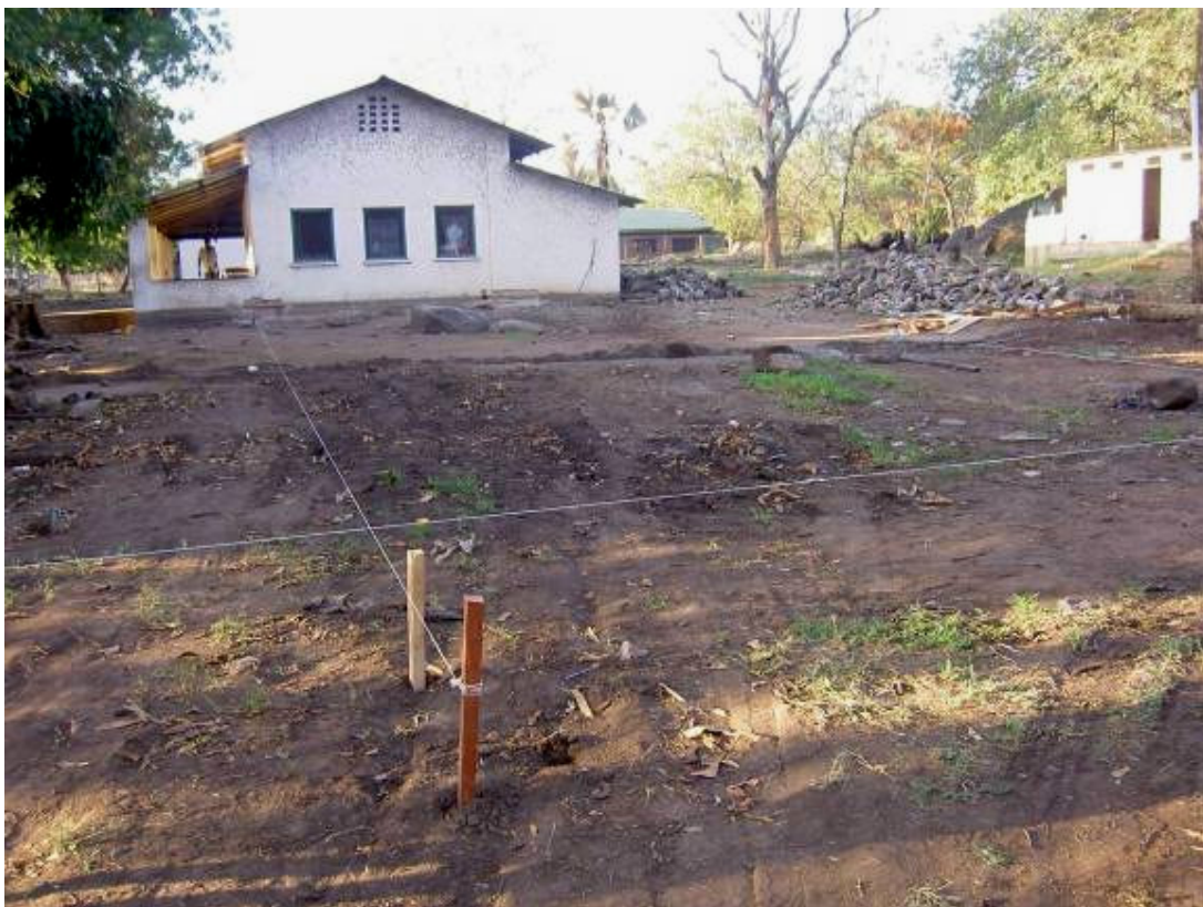
Tracciamento delle fondazioni (maggio 2011)
