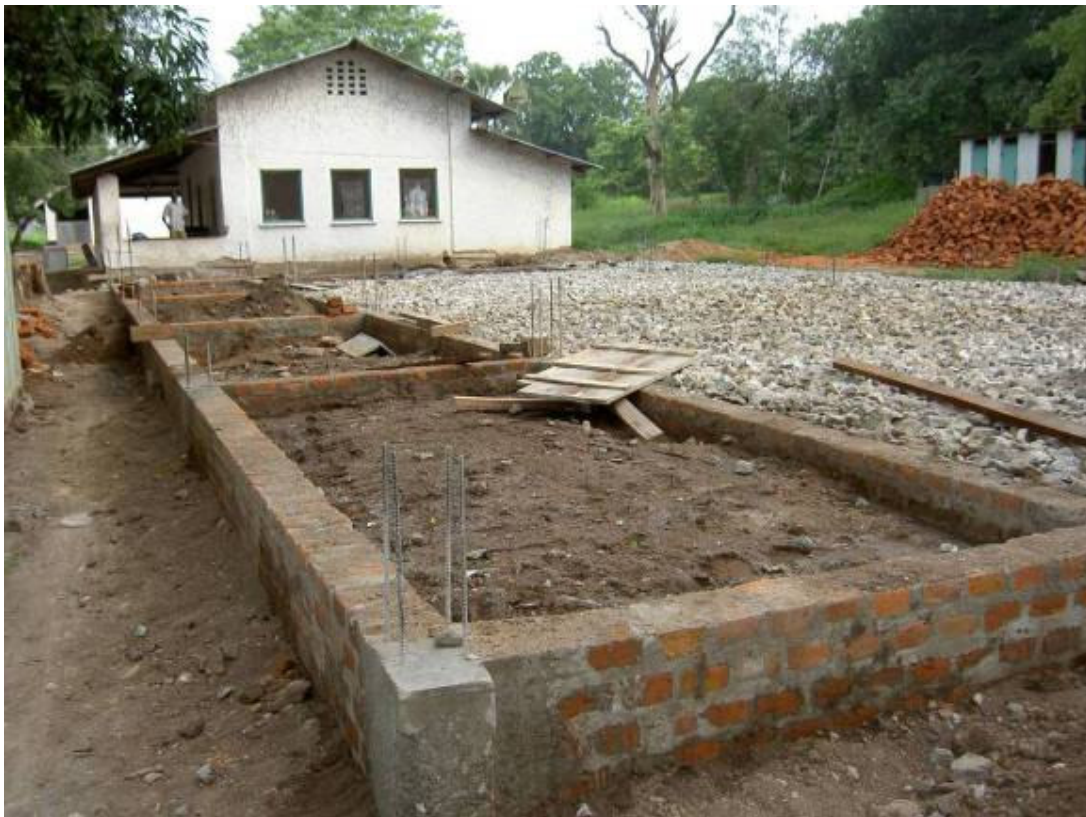
Realizzazione delle fondazioni (luglio 2011)
