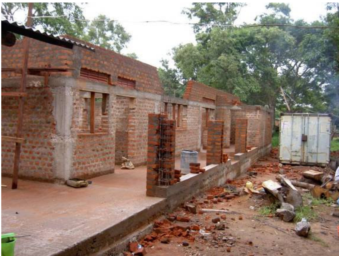
Realizzazione del cordolo e delle colonne della veranda e (31 agosto 2011)
