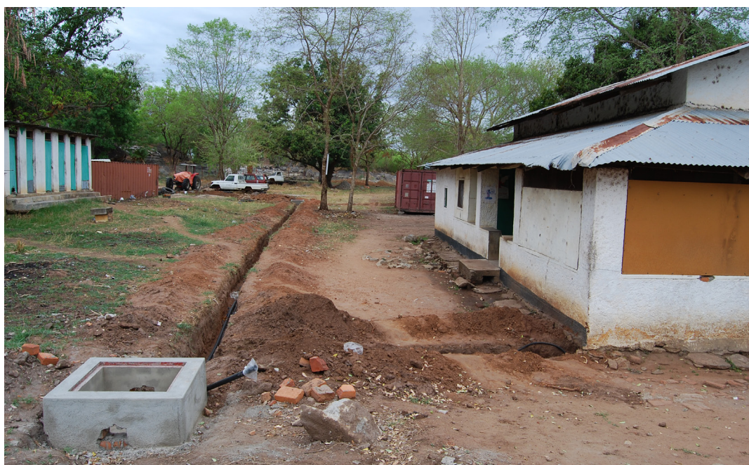
In questa pagina: scavi per l'impianto idrico ed elettrico; nella pagina accanto: scavo delle fondazioni per la nuova sala parto.
